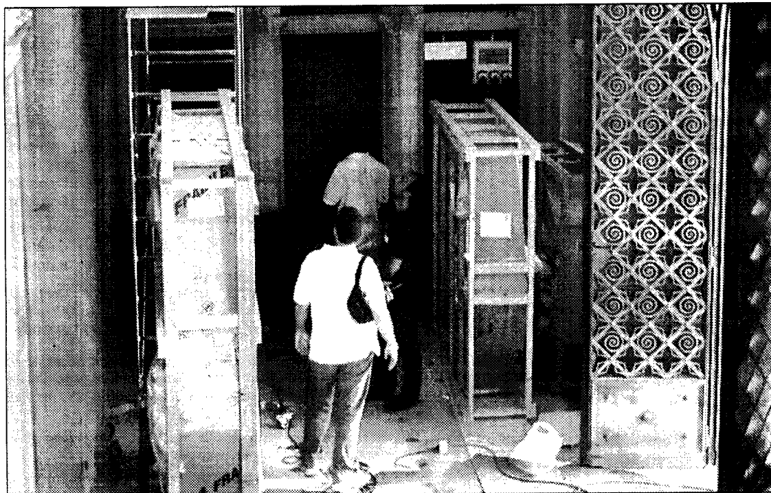
Operai in azione in uno degli ingressi del Palazzo Genoese Zerbi
